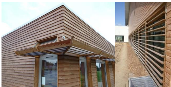
Exemple de brise-soleil pouvant être mis en place.
