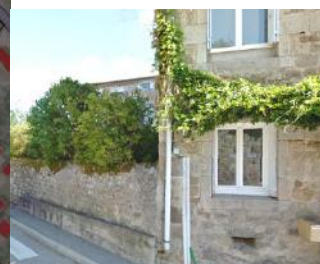
Mur, rue du Marronnier.
