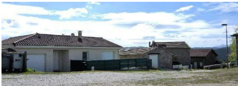
Construction récente, intégrée en cœur de centre ancien. La hauteur est adaptée au contexte.
