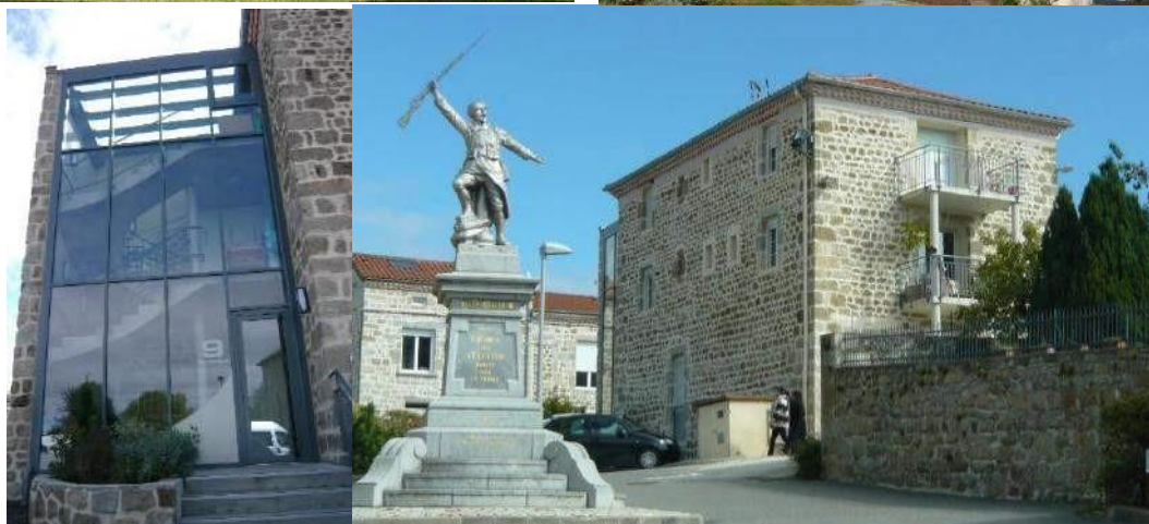
Réhabilitation - Logements sociaux.
