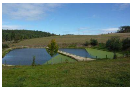
Station de Trevas.
